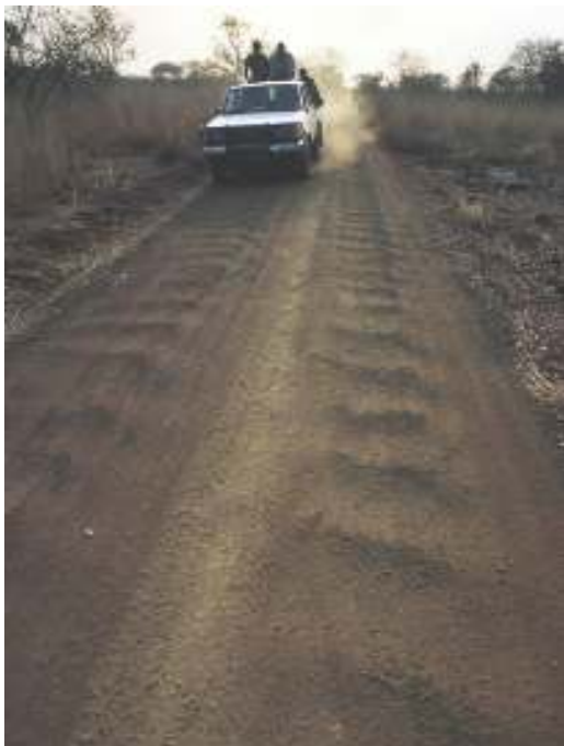
Image 54 : Circulation gênée par des ornières
