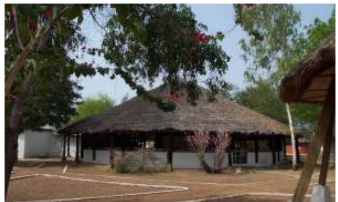
Image 45 : bâtiment central de l'hôtel Pendjari
